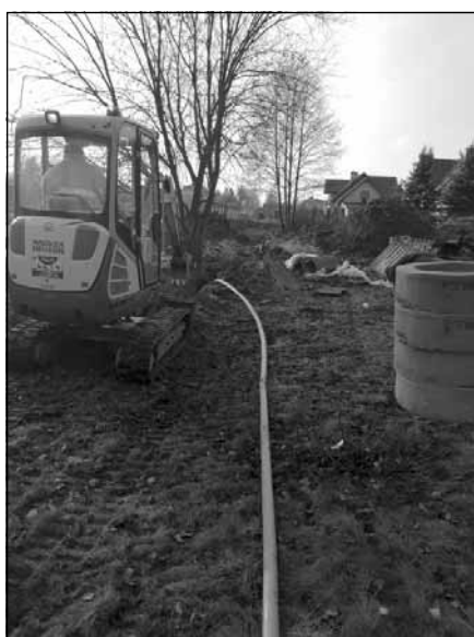
Rozbudowa sieci gazowej na Piaskach od Niepublicznej Szkoły Podstawowej w kierunku Bud Głogowskich.
