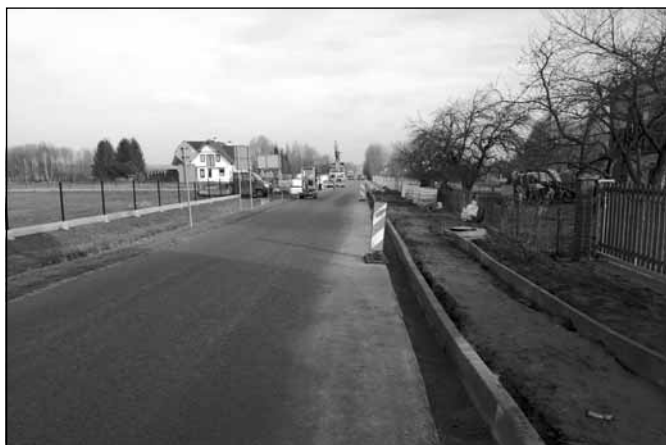
Budowa chodnika na Piaskach od Niepublicznej Szkoły Podstawowej w kierunku Bud Głogowskich.
