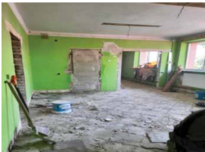
Filia w Mrowli przed remontem i po jego ukończeniu
