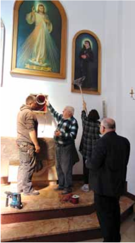
Ks. kan. J. Książek nadzoruje montaż Relikwiarium.
