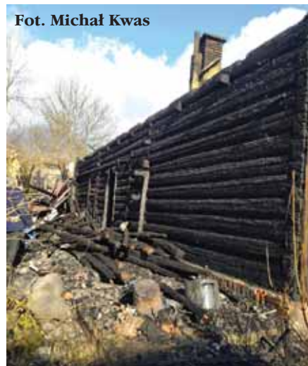
Spalone ściany budynku.
