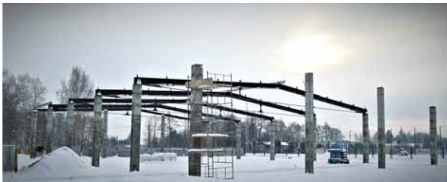
Wiata w trakcie budowy – grudzień 2022 r.
