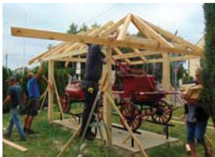
Budowa wiaty pod zabytkową sikawkę.
