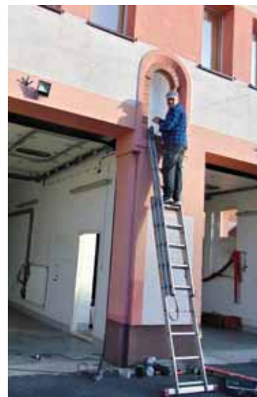
Montaż oświetlenia we wnęce na figurkę św. Floriana.
