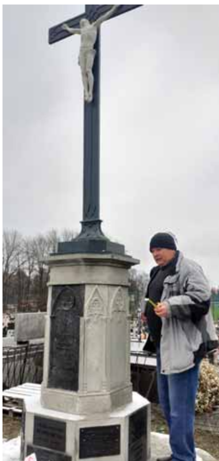
Andrzej Wróbel przy wykonywaniu zabezpieczających nagrobek obróbek blacharskich.
