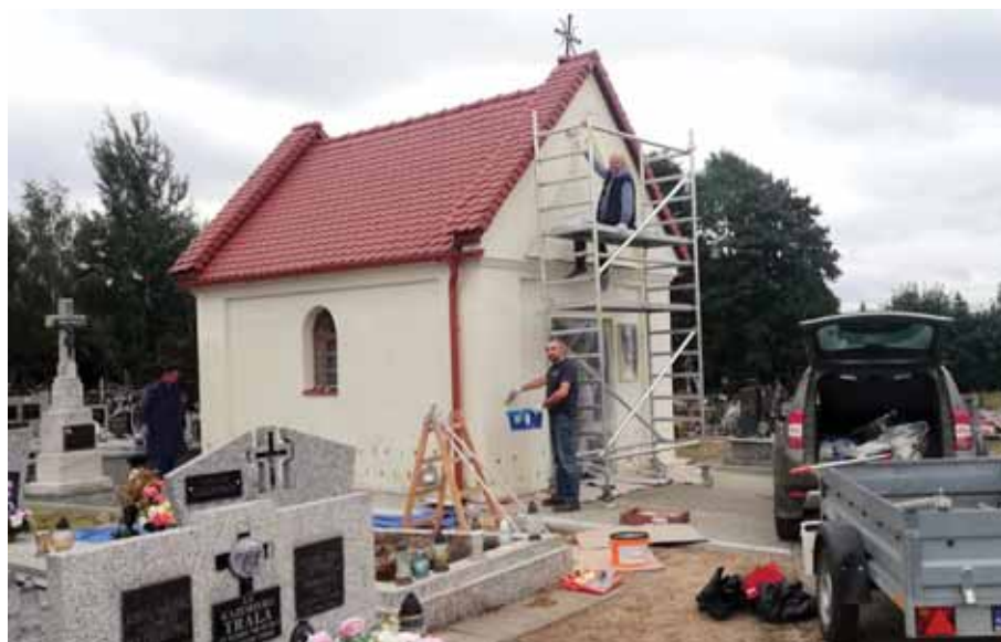
Malowanie zewnętrznej elewacji kaplicy Krupnickich i Kirchnerów.
