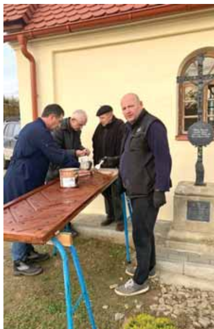
Malowanie drzwi kaplicy cmentarnej.
