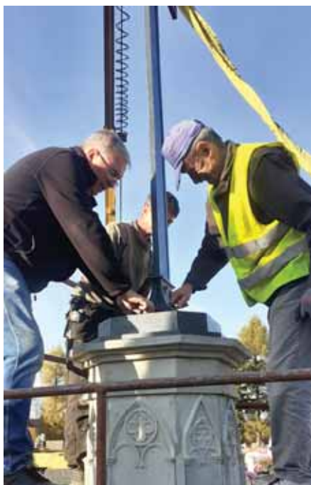
Instalowanie odnowionego krzyża.
