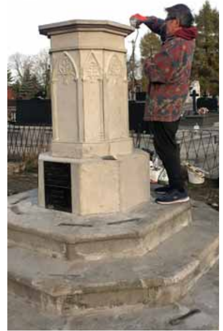
Odtwarzanie cokołu nagrobka.
