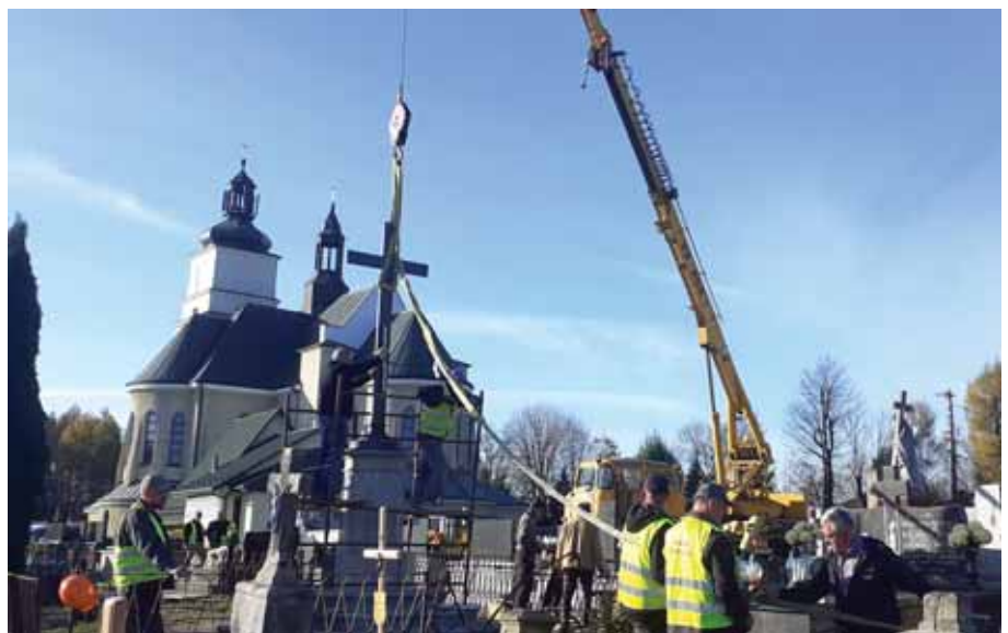
Prace przy użyciu dźwigu p. Zdzisława Pachorka.
