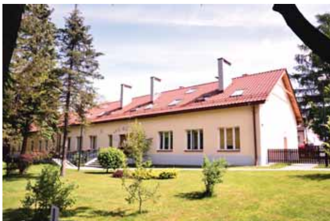
Obecny kształt dawnego folwarcznego budynku gospodarczego po adaptacji na przedszkole i żłobek dla dzieci.
