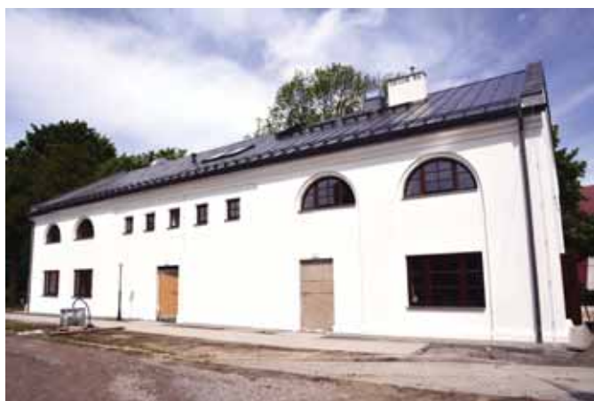
Były budynek spichlerza w trakcie przebudowy na Dom Seniora.
