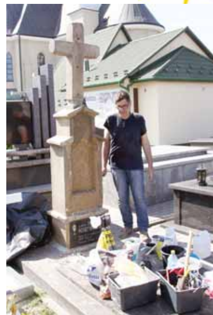
Prace przy renowacji nagrobka ks. Ignacego Węgrzynowskiego w Świlczy.
