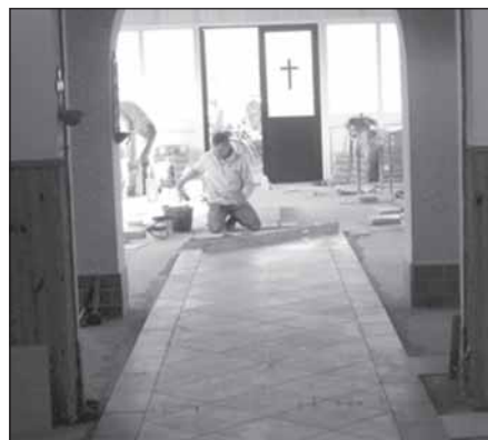
Układanie płytek w kaplicy cmentarnej.
