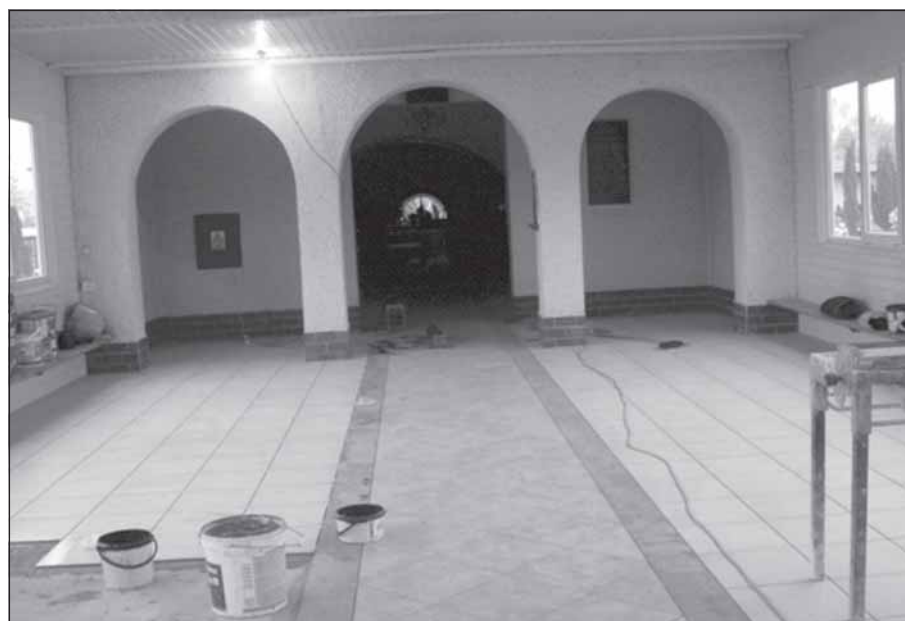
Prace przy układaniu płytek przebiegały sprawnie.
