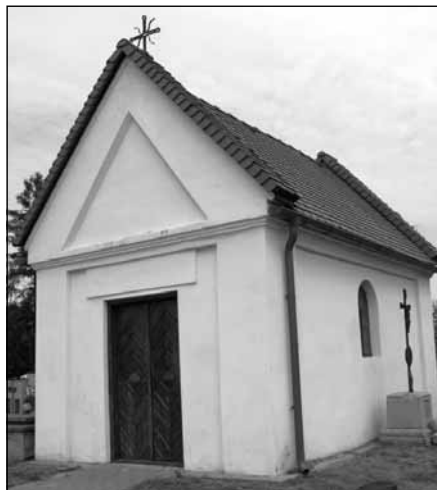
Widok kaplicy odrestaurowanej w latach 2009/2010. Przy wschodniej ścianie widoczny nagrobek Józefa Krupnickiego. Fot. A. Szary
