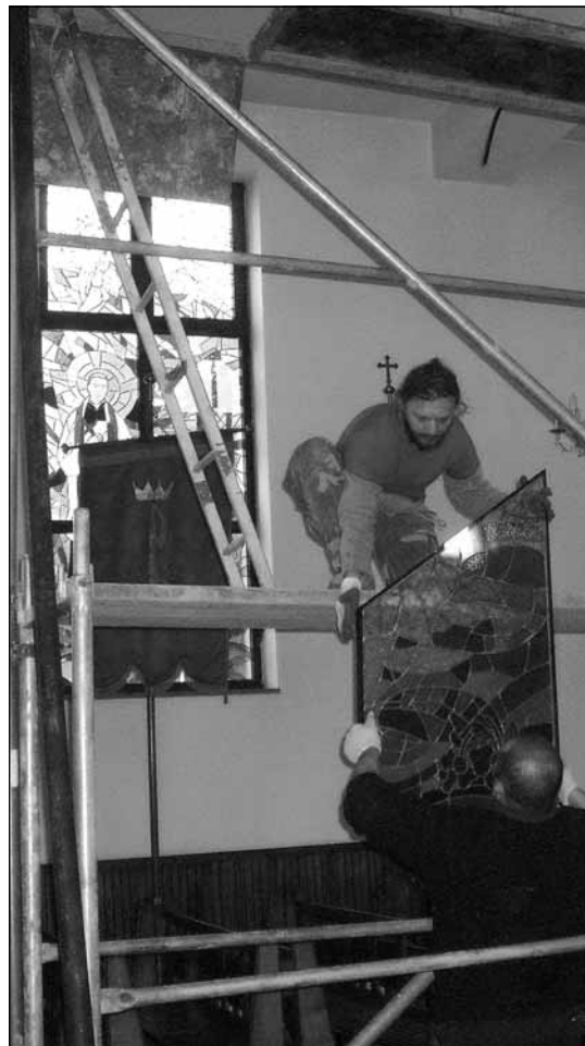
Montaż witraży. W dolnej części zdjęcia W. Kirsz.
