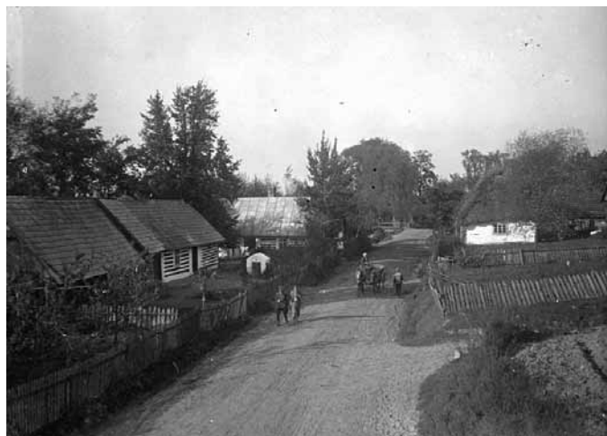
Widok z mostu kolejowego na drogę w kierunku północnym.
