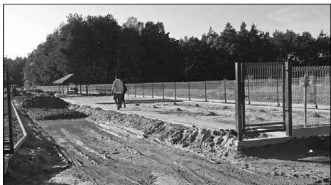
Prace budowlane obiektu sportowo-rekreacyjnego „Czekaj” w Bratkowicach, Bratkowice-Czekaj, wrzesień 2014.
