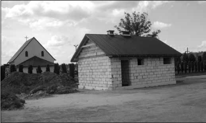
Budynek administracyjno-gospodarczy na placu targowym w Bratkowicach, w trakcie budowy (28.05.2014 r.).
