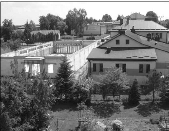
Budowa obiektu handlowego w centrum Bratkowic.
