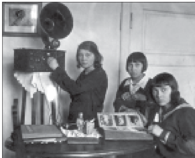
Śluchaczki radia przy odbiorniku wczesnego okresu lampowego z dołączonym głośnikiem tubowym. Ok. 1926 r. (źródło: www.historiaradia.neostrada.pl ).
