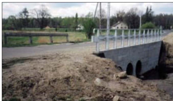
Remontowany most w Bratkowicach.
