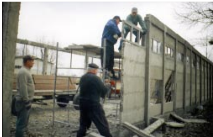
Prace przy rozbiórce wiaty garażowej w Bratkowicach.
