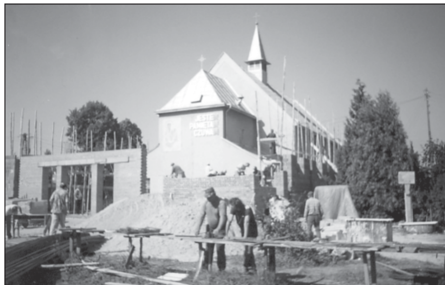
Trwają prace przy rozbudowie kościoła w Bratkowicach
