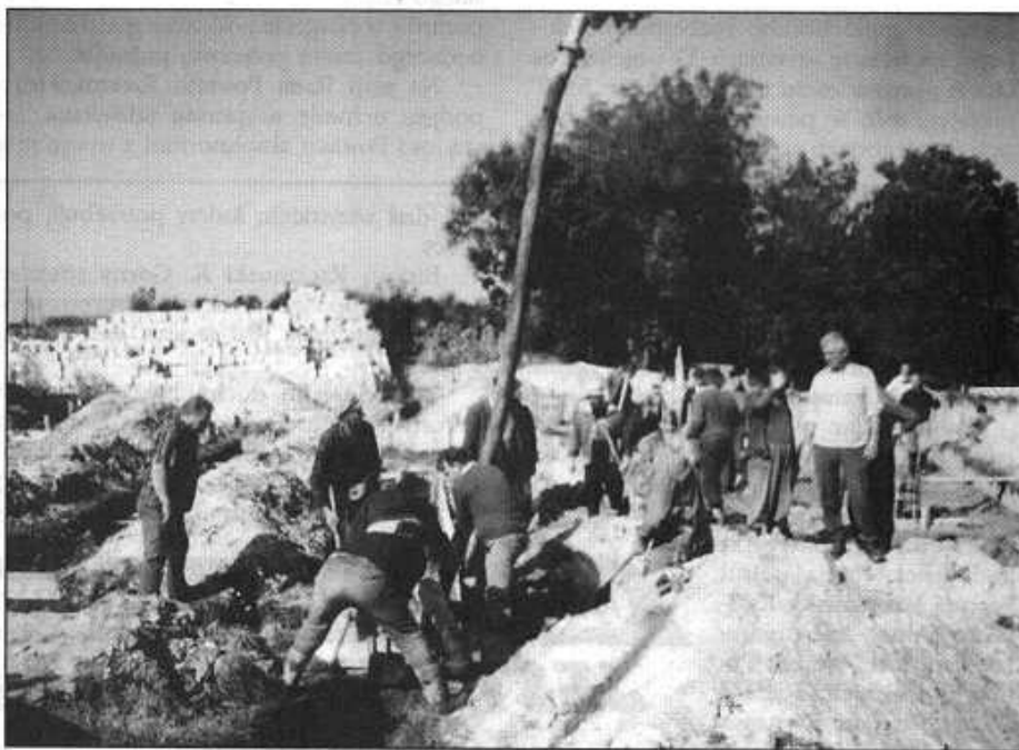
Rozpoczęcie budowy (wykonanie ław fundamentowych).
