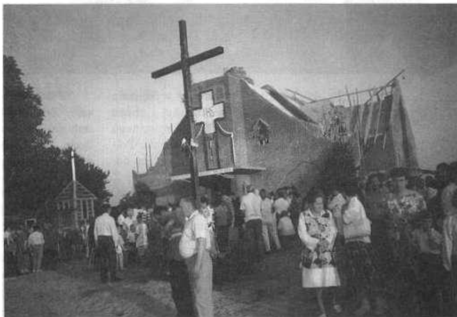
Nowo budowany kościół w Pustkach.
