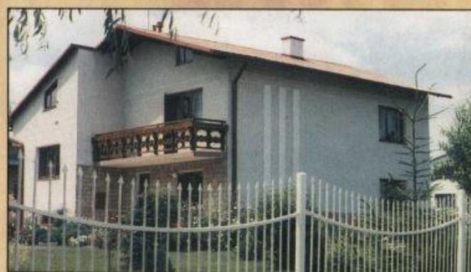
Wieś pięknieje. Stare drewniane budownictwo w zaniku. Willa taka jak ta to powszechność.
