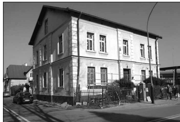
Dom Kulów przy ul. Towarnickiego – stan obecny.
