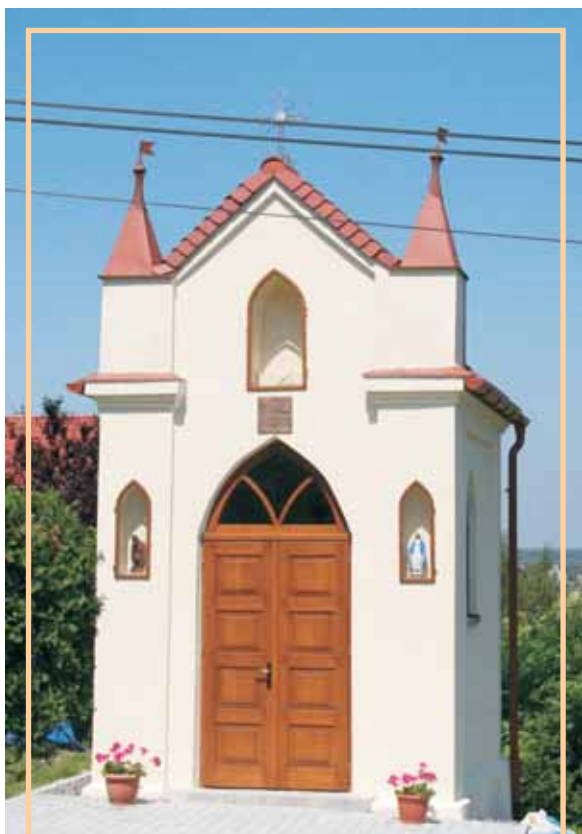
Zabytkowa kaplica w Dąbrowie. Renowacja 2010 r.
