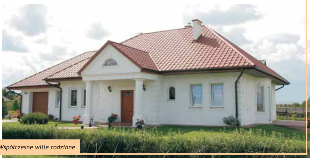
Budownictwo murowane piętrowe
