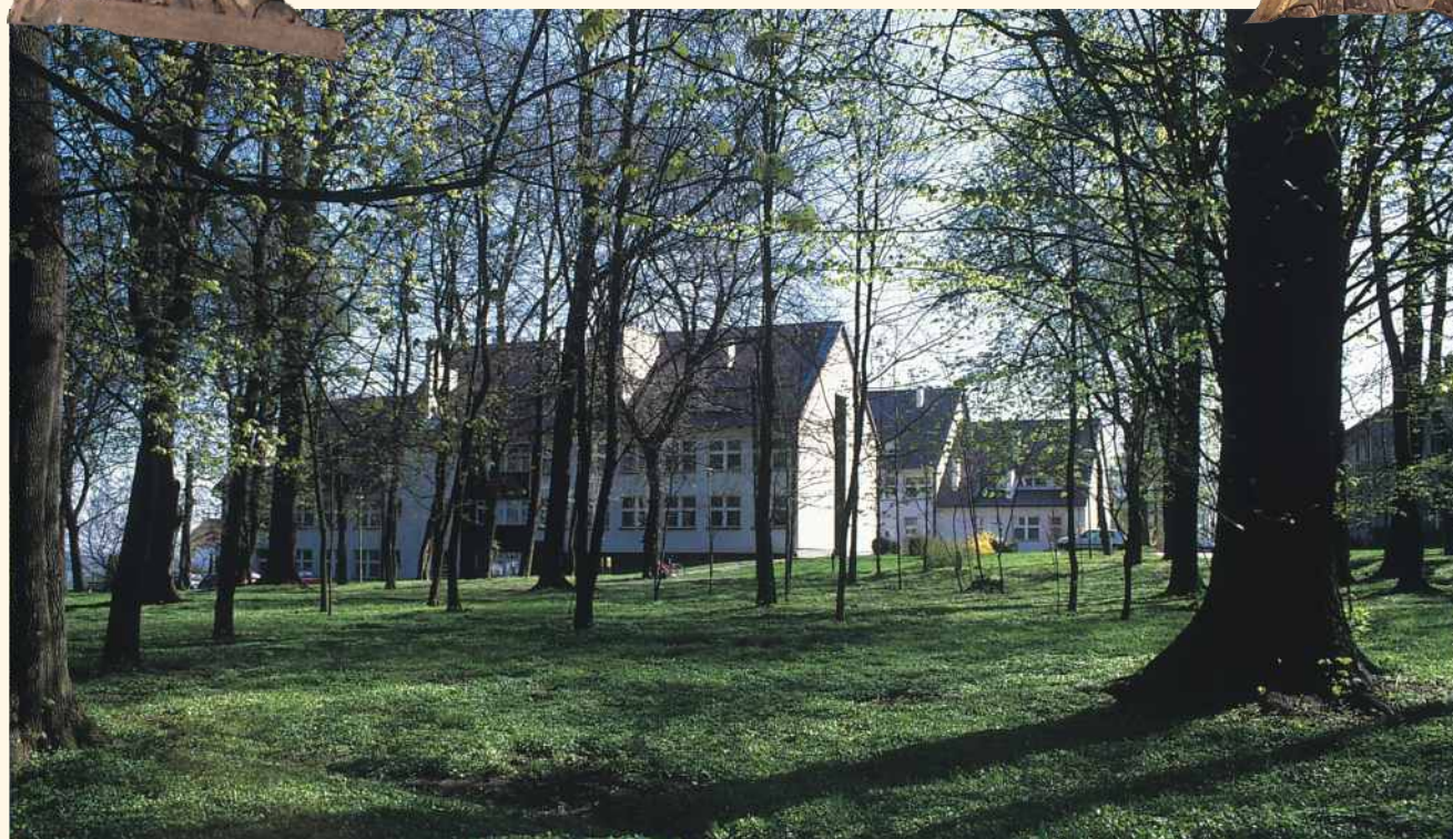
Kompleks budynków Zespołu Szkół RCKU w Trzcianie wybudowany w parku podworskim
