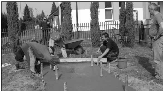
Betonowanie podestu pod ustawienie sikawki.
