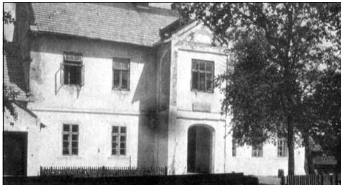
Budynek szkoły ludowej w Świlczy wzniesiony w 1881 roku, a rozbudowany w latach 1886-1900. Od lat 30. XX wieku w budynku tym mieścił się posterunek policji. Fot. ze zbiorów K. Mikosza
